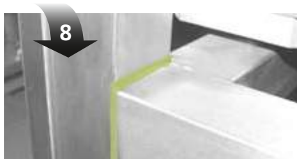
8 Durchgezogene Schweißnähte mit geschliffenen und nachbehandelten Oberflächen Continuous welding seams with ground and treated surfaces
